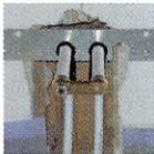
Installation der Anschlussbrücke, anschliessend Druckprobe
