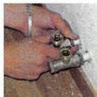
Installation der Verschraubungen/Anschlüsse entsprechend den gewählten Radiatoren
