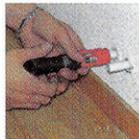
Auf's Mass Schneiden der Verbundrohre entsprechend den gewählten Radiatoren
