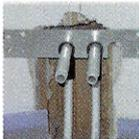
Montage von Vor- und Rücklauf mittels Flipflex-Rohre, Wand-schiene und Schutzrohre
